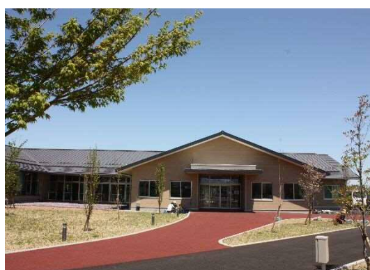
新築共和寮（整備作業）
